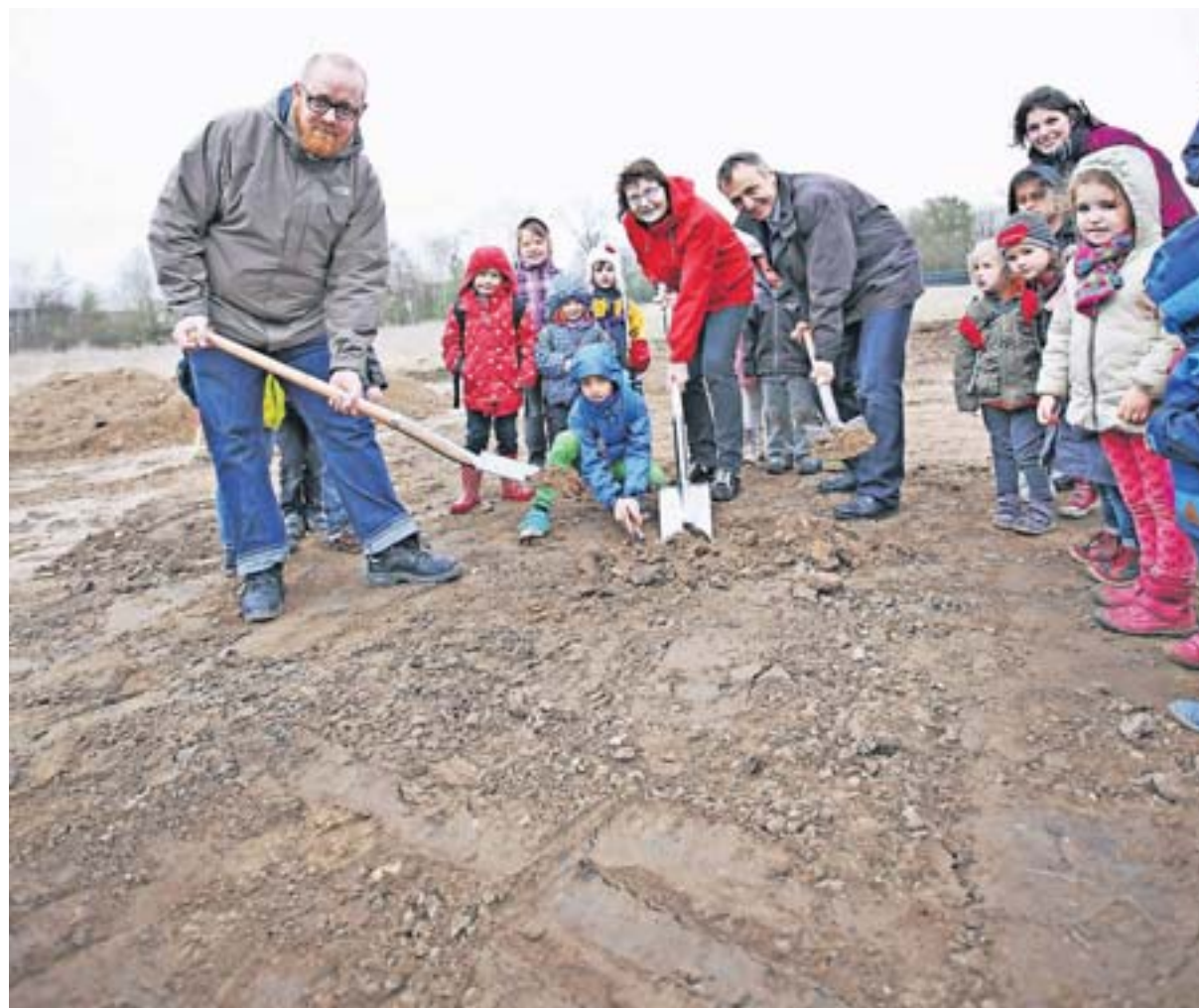
Kindergartenkind Lasse (6) durfte gestern mit Stadt-Architekt Bryan McDonough, Bürgermeister Franz-Josef Moormann und Kita-Leiterin Monika Hartings den ersten Spatenstich für die Kita „Am Wald“ vornehmen.
